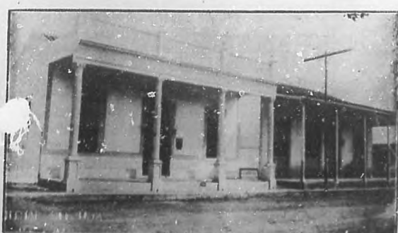
LA CLINICA PLACETAS.—Fachada principal del edificio.
